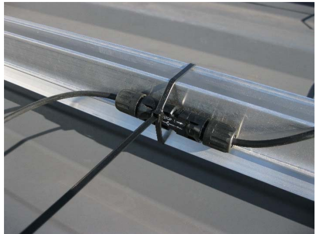
Exemple de cheminement des câbles
