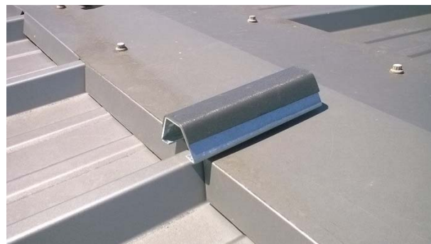
Positionnement des rehausses de faitage : une seule par colonne de rails
