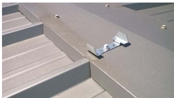
Positionnement des rehausses de faitage : une seule par colonne de rails
