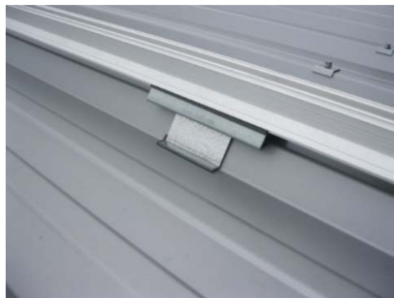
Figure 26 - Fixation du rail sur la rehausse de blocage ou la rehausse supérieure
