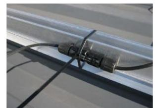
Il sera ménagé un degré de liberté suffisant aux câbles de raccordement sous chaque module, afin de permettre le pivotement du panneau pour accès aisé aux connecteurs en vue de maintenance ou remplacement.
